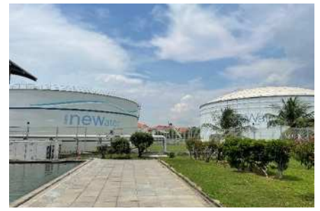
下水再生水“Newater”の処理工場
